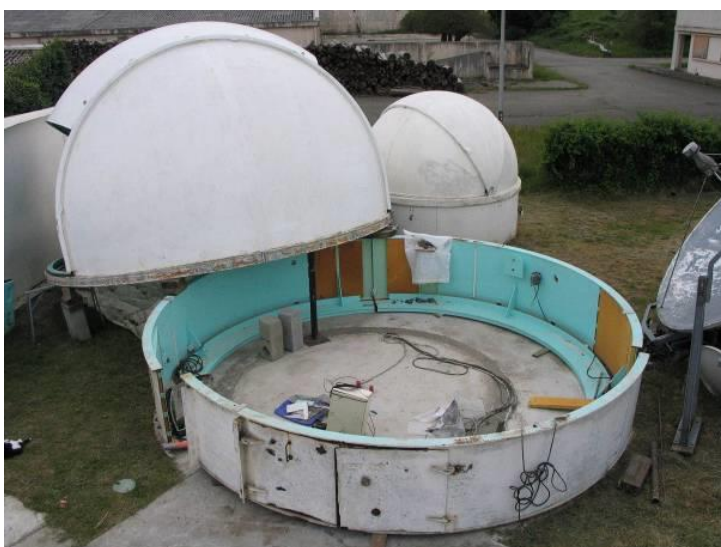
Fig. 32 - Remontage et assemblage de la coupole de 5 m en 2014.
